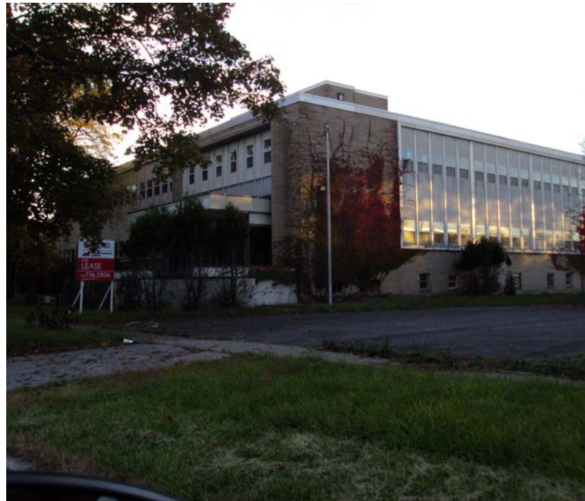
Existing PAR Technologies Building
